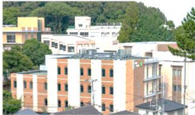
8号館 南西面遠景 (山の中に学舎)
